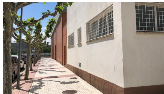
FACHADA LATERAL S-E
