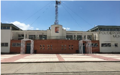
FACHADA PRINCIPAL N-E (foto de archivo antes de intervenciones)
