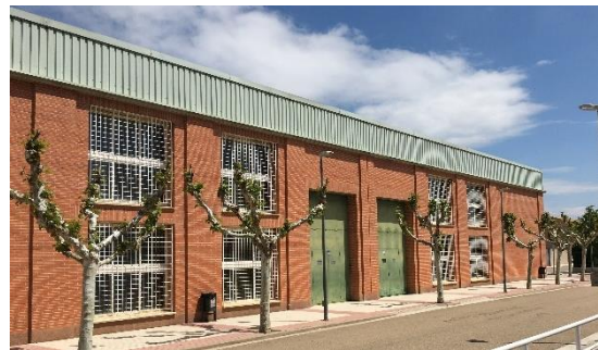
FACHADA S-O (foto de archivo antes de intervención de cota 0)
